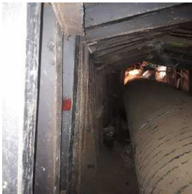
۳۰- حفاری تونل به روش فول فریم با استفاده از IPE16
