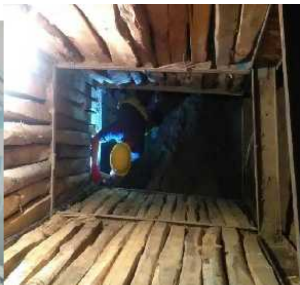
۲۸- اجرای سازه نگهدارنده میل چاه و چوب فرش
