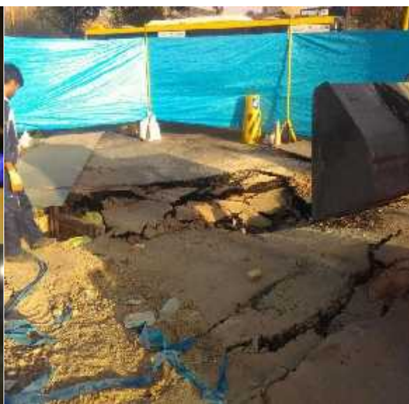
۲۴- نشست شدید زمین به دلیل نشت لوله آب
