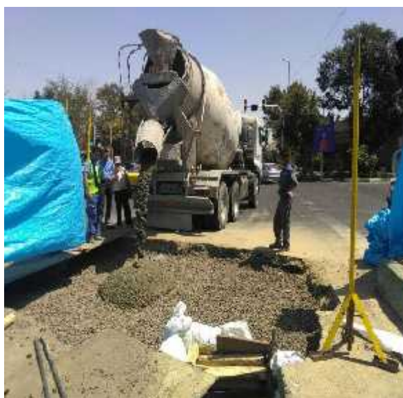
۲۷- بتن ریزی محل نشست تا سطح آسفالت
