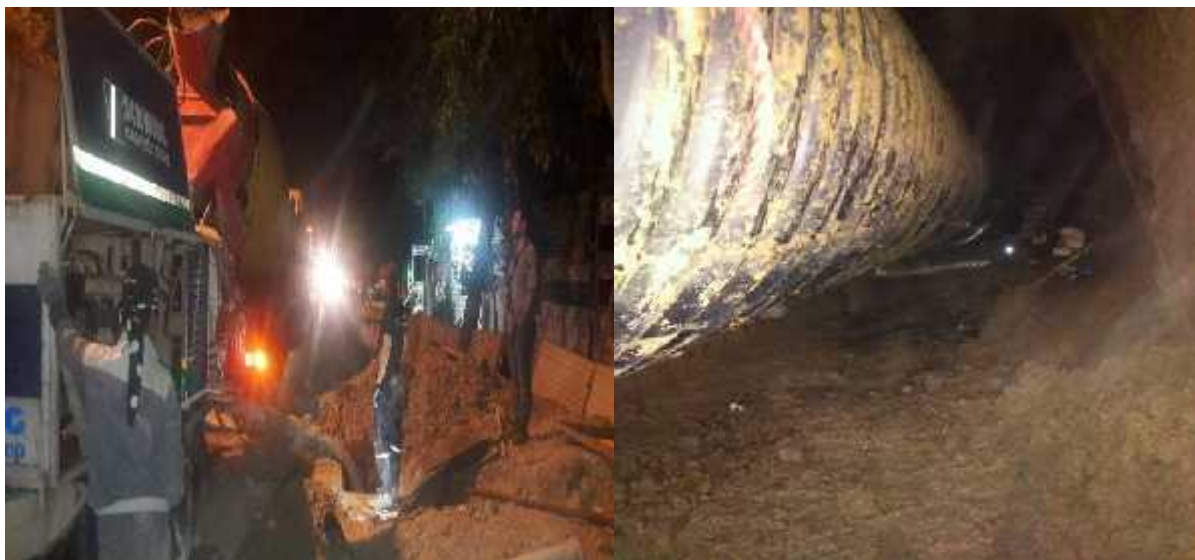
۵- بتن ریزی مسیر کار شده
