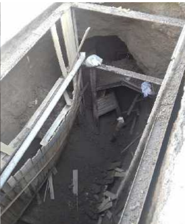
۱۰-نصب سازه نگهدار
