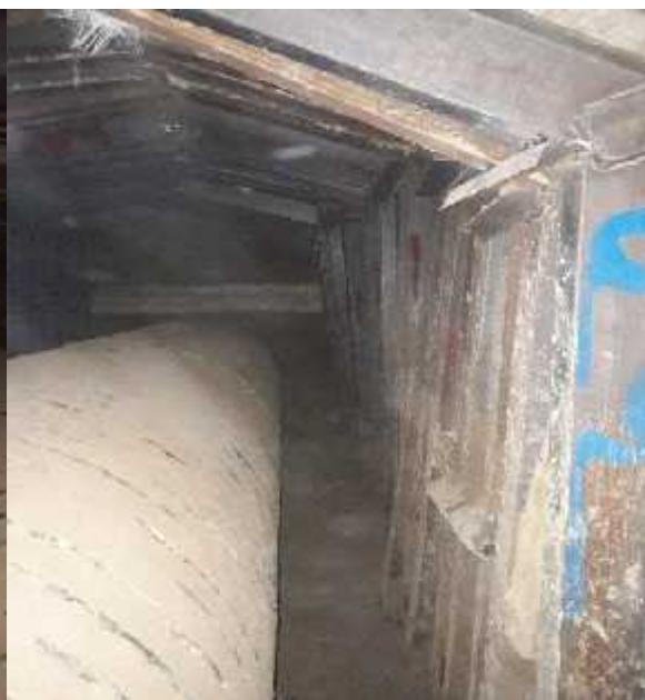
۳۰- حفاری تونل به روش فول فریم با استفاده از IPE16
