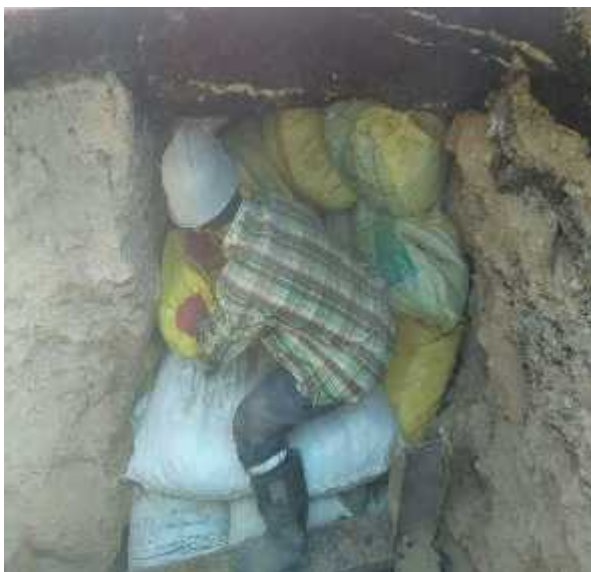
۱۸- پر کردن محل ریزش با پوکه معدنی و بتن سبک
