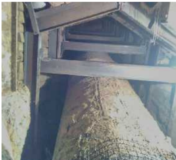
۲۹- مهار کردن لوله ۹۰۰ میلیمتر
