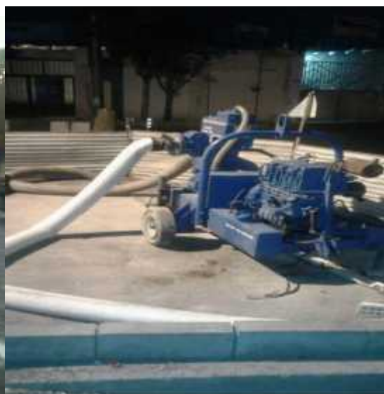
۲۲-انحراف مسیر فاضلاب لوله ۵۰۰ میلیمتر با پمپ دیزل خودمکش ۶ اینچ در ۱۲ ساعت شب
