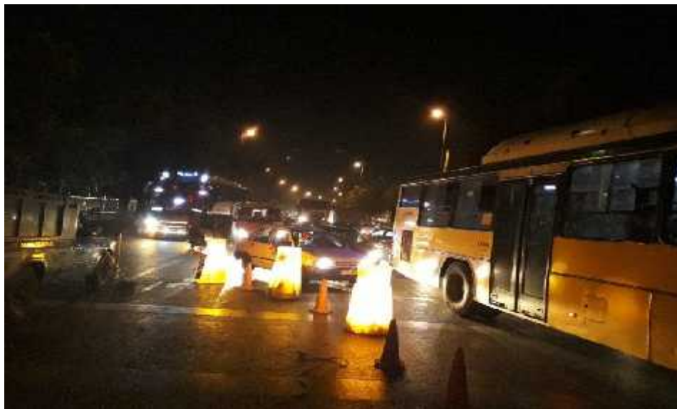
۱۶- بار ترافیکی سنگین خیابان در زمان اجرای کار
